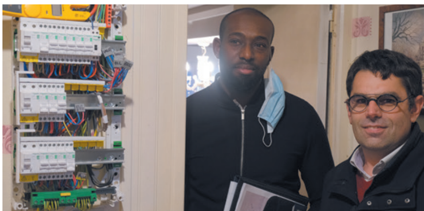
Le responsable de Batéco, entreprise de travaux de rénovation et le fondateur de REH, Franck Billeau
